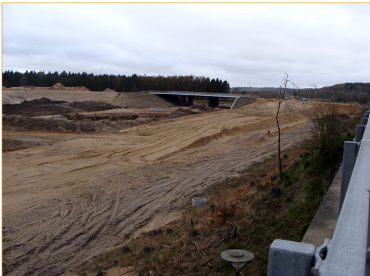
Motorvejsbyggeri ved Silkeborg, april 2014.
