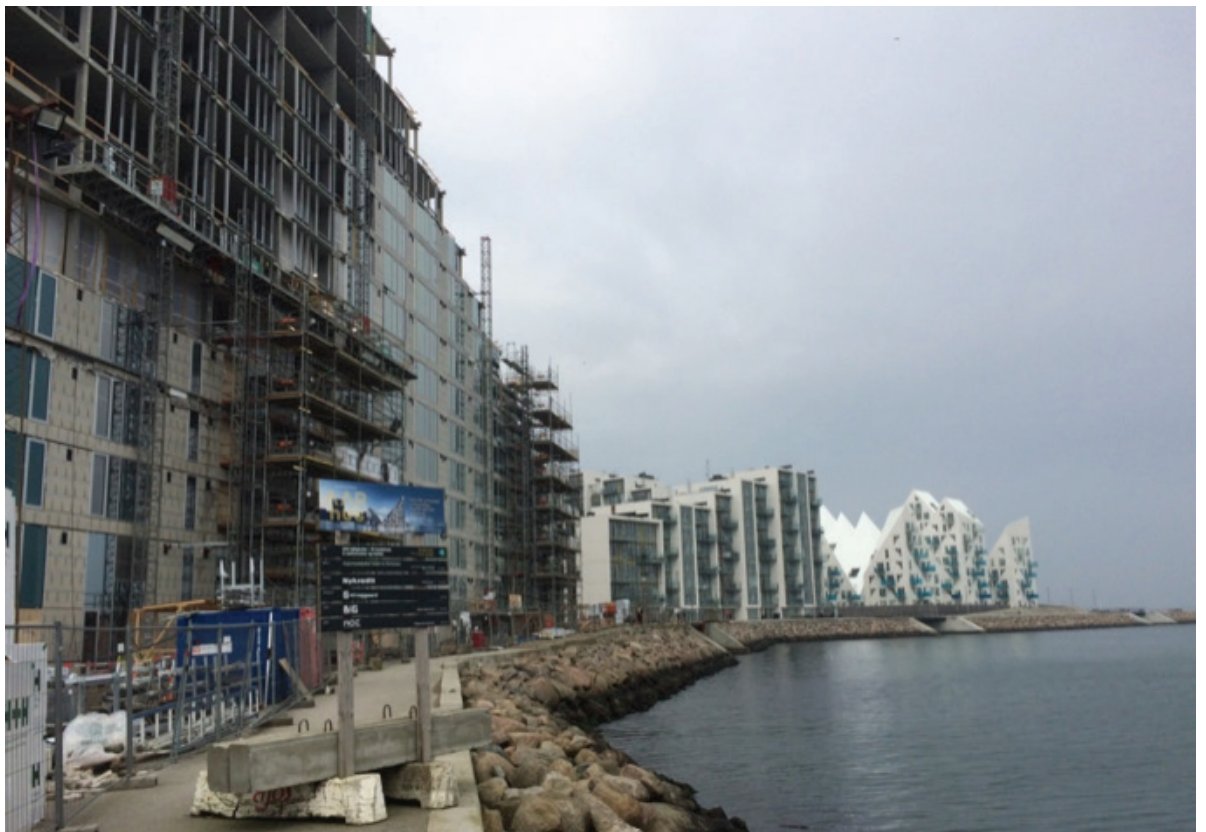
Billede 4. Betonbyggeri på Aarhus Ø, Aarhus kommune. 2018
