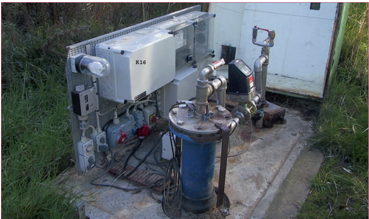
En afværgestation på Eskelund Losseplads ved Århus. På lossepladsen foregår bl.a. afværgepumpning og monitorering af forurenings-situationen.
