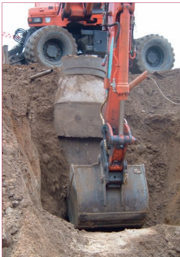
En olieudskiller og den omkringliggende forurenede jord bortgraves.
