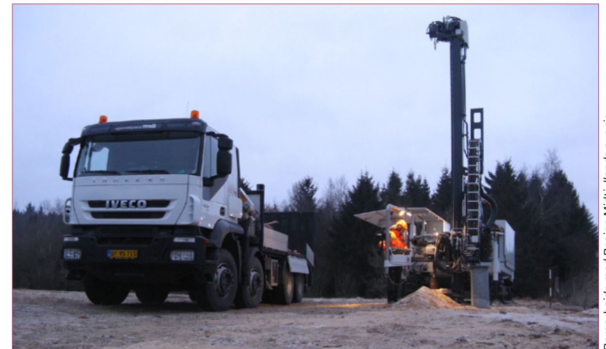
Borearbejde med Region Midtjyllands nye rig
