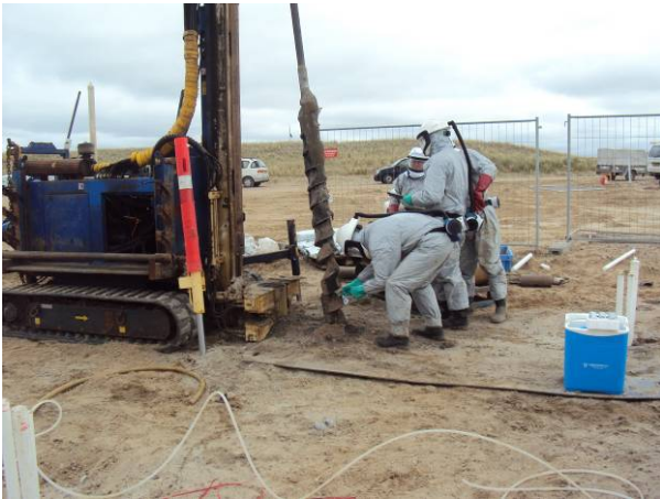
Forsøgsarbejde ved Høfde 42
