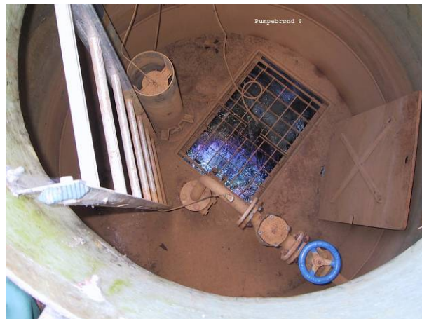
Pumpebrønd, hvorfra forurenede vand oppumpes og sendes til rensning
