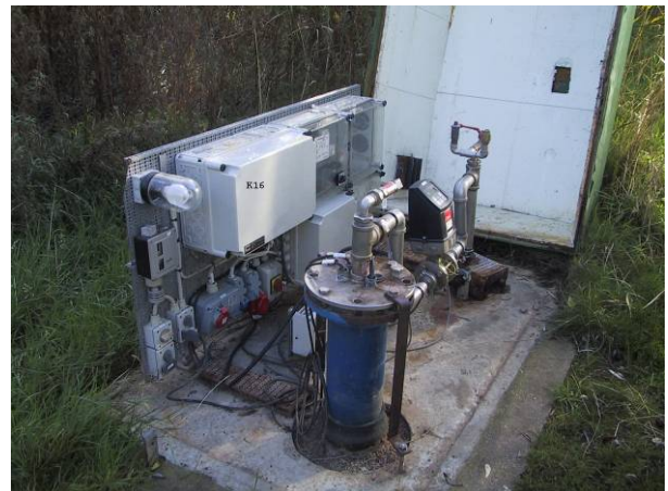
Afværgestation, hvorfra oppumpning af forurenede vand kan styres og reguleres
