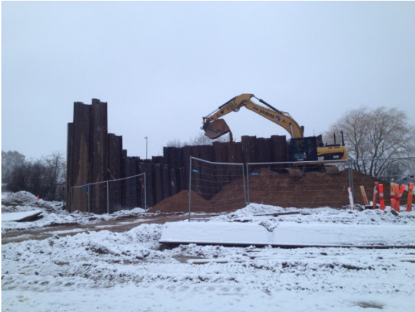
Afværge ift. grundvand Gl. Sellingvej
