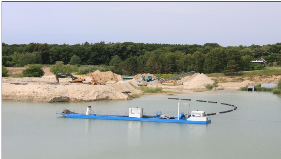
Figur 2-3: Råstofgraven Store Rosenbusk. Sediment pumpes fra den blå pram til det inddæmmede område, som ses i baggrunden til venstre. På billedet er gravemaskinerne i færd med at fjerne oppumpet sediment.
