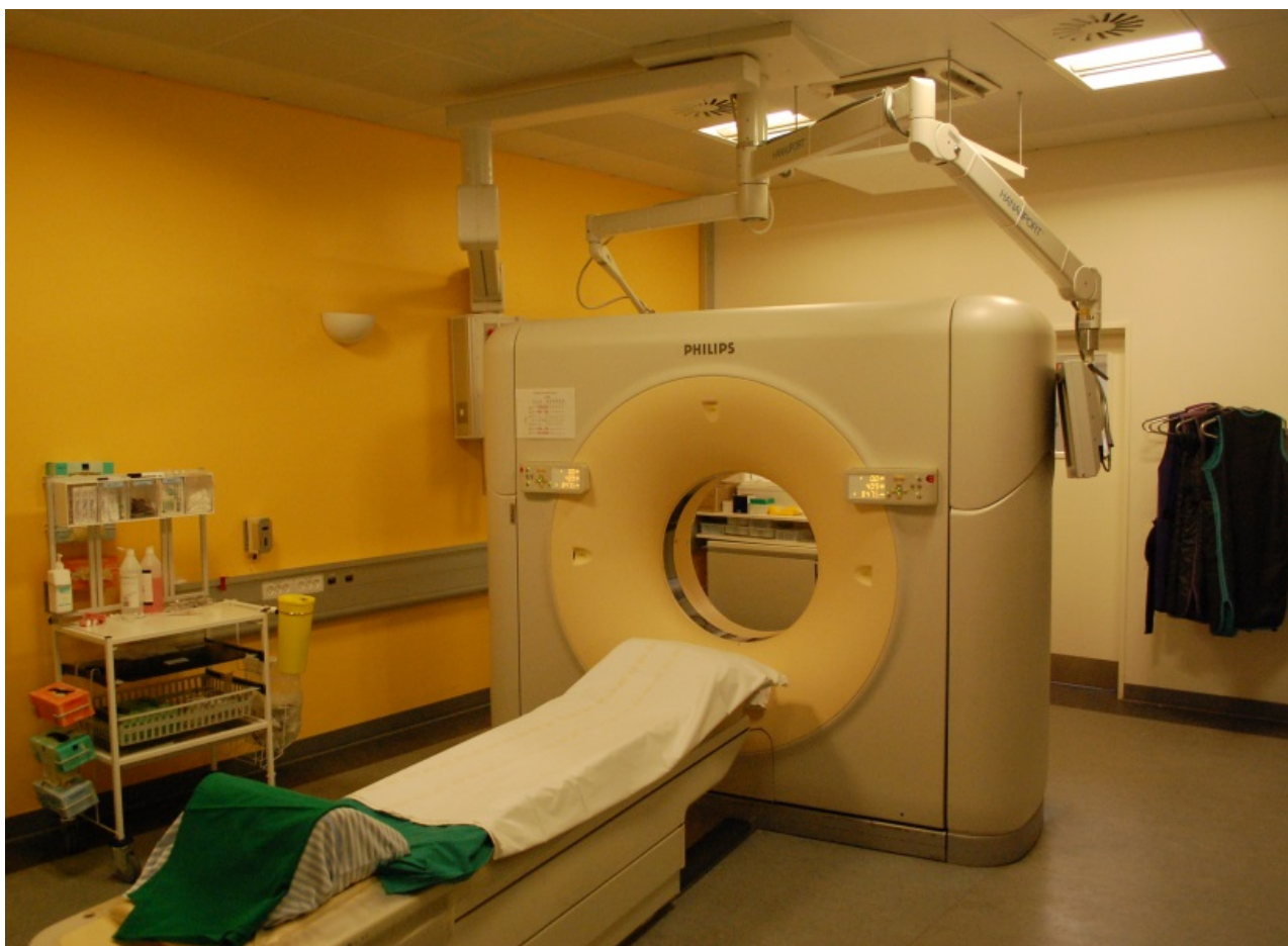
Figur 7: Eksempel på CT-skannerrum med sprøjtepumpe, skærm og udtag til ilt og sug placeret på mobile arme i loft, så de er tilgængelige fra begge sider af gantry, Aarhus Universitets-hospital.
