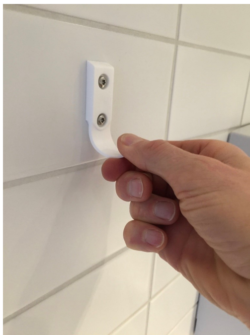
Eksempel på knage, hvor der ikke kan fastgøres ligatur
