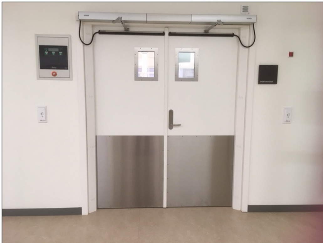
Figur 9: Eksempel på to-fløjet dør, hvor hver fløj kan åbnes enkeltvis, men også samlet, Aarhus Universitetshospital
