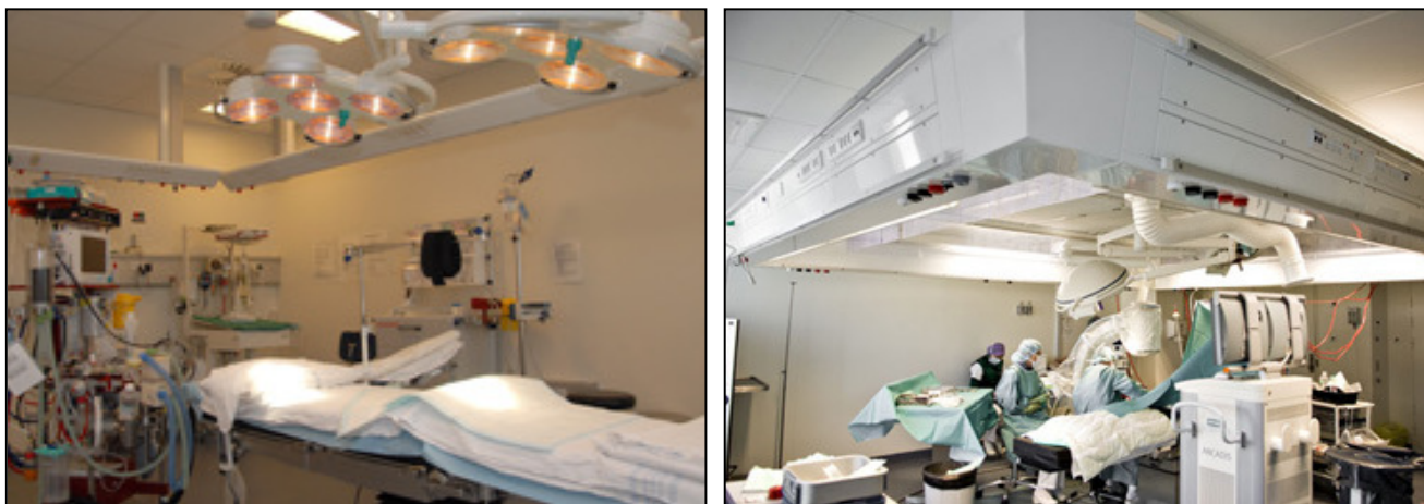
Figur 22: Loftmonteret bro, hhv. Hospitalsenhed Midt og Rigshospitalet Glostrup
