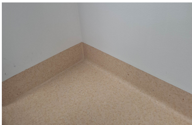
Figur 4: Eksempel på gulvafslutning, Operationsstue, Regionshospitalet Viborg
