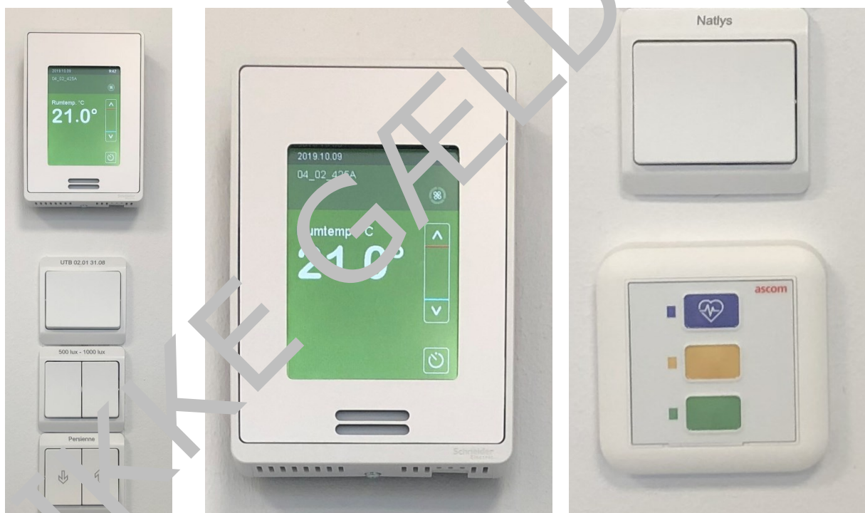
Ill. 11 Eksempler på betjeningspaneler til henholdsvis temperatur, lys og persienner (billede 1 og 2) og patientkald og natlys (billede 3)
