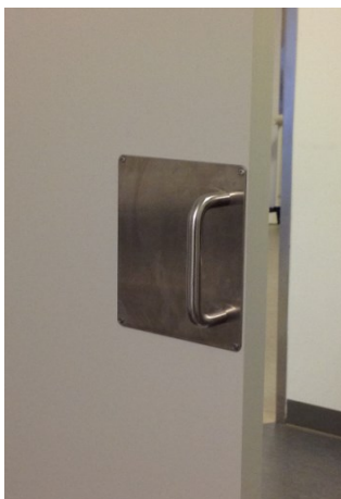
III. 6 Eksempel på dørhank. Dørhank på skydedøre placeres så tæt på dørens forkant som muligt.
