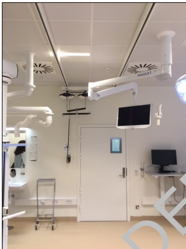
Figur 4: Placering af loftbægt udstyr, så det ikke kolliderer med hinanden
