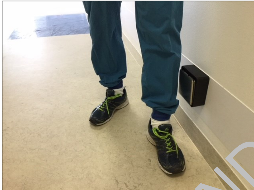
Figur 9: Døråbning med læg-/fodbetjening
