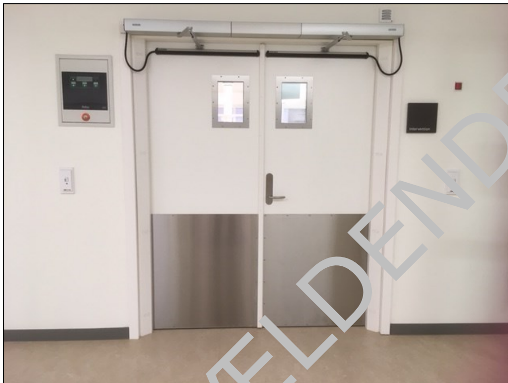
Figur 8: Eksempel på to-fløjet dør, hvorefter hver fløj kan åbnes enkeltvis men også samlet, Aarhus Universitetshospital
