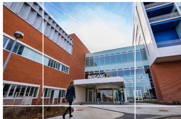
Det nye hospitalsbyggeri i Skejby står nu næsten færdigt, og de første afdelinger er allerede rykket ind. Foto: Tonny Foghmar
