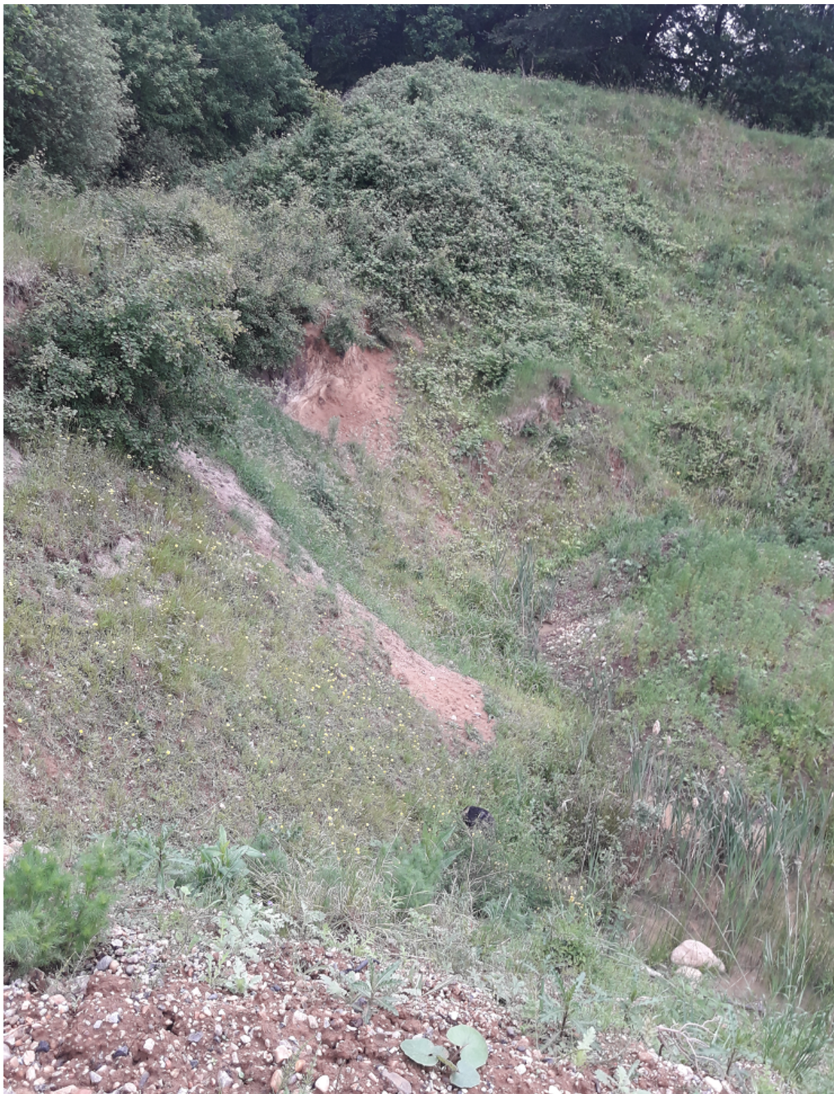
Jordvold og udgravning tæt op ad mose (10-15 meter), mod øst.
