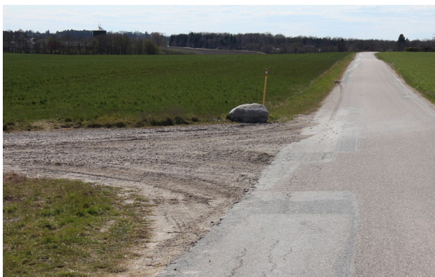
Figur 9.2 Eksisterende overkørsel til Holbækvej. (LE34, 2021)
