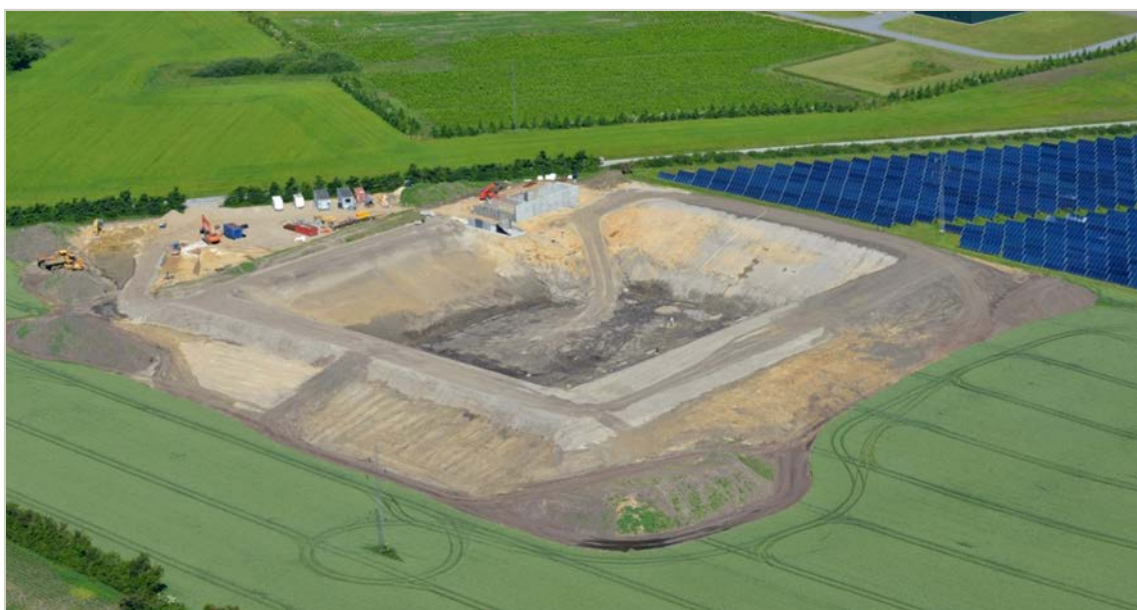
Figur 247 Solvarmeanlæg og sæsonvarmelager under udførsel
