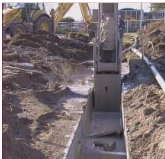
Etablering af reaktiv væg ved BM-Controls. Væggen går 16 meter ned i jorden.
