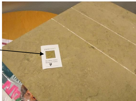
#11 Udtagning af MMS7 (MV=6) på ikke-nedtaget plade. Plade er "oprindelig" og markant mere gul end nyere plader.
