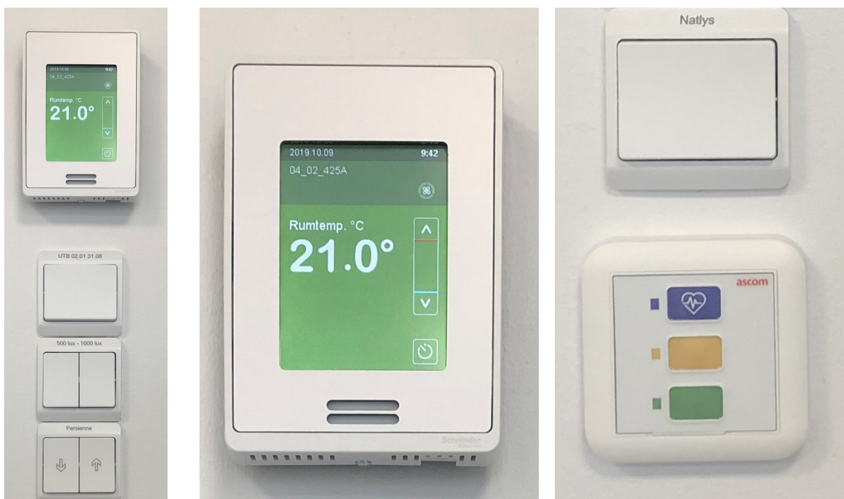
Ill. 11 Eksempler på betjeningspaneler til henholdsvis temperatur, lys og persienner (billede 1 og 2) og patientkald og natlys (billede 3)
