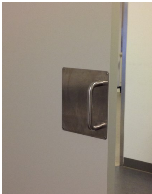
III. 14 Dørhank på skydedøre placeres så tæt på dørens forkant som muligt
