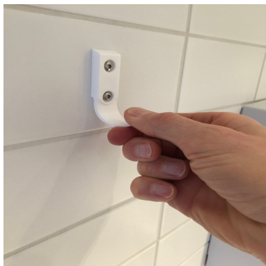
Eksempel på knage, hvor der ikke kan fastgøres ligatur.
