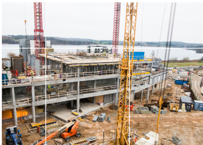
Det nye akutcenter på Regionshospitalet Viborg rejste sig i 2016 fra kælder til etage 4. Også på HE Midts øvrige hospitaler i Silkeborg, Hammel og Skive har håndværkerne haft travlt med ny- og ombygninger. Foto Lisbeth H. Justesen
