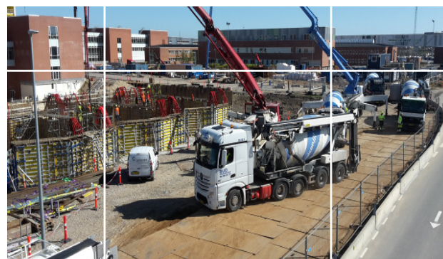
Byggeriet af Dansk Center for Partikelterapi er i fuld gang. I 2016 blev der ansat en afdelingsledelse. Foto Projektafdelingen for DNU
