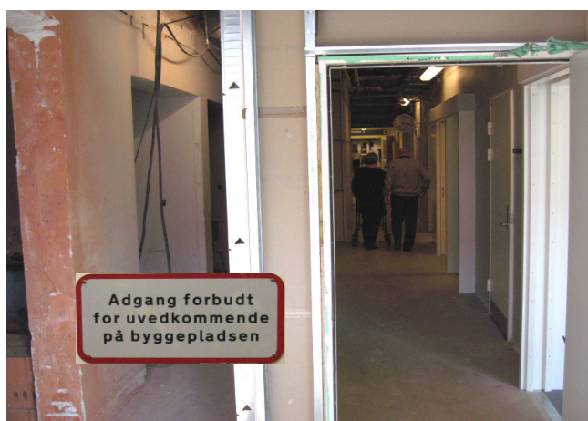
En del af stråleafdelingen er afspærret på grund af ombygning
